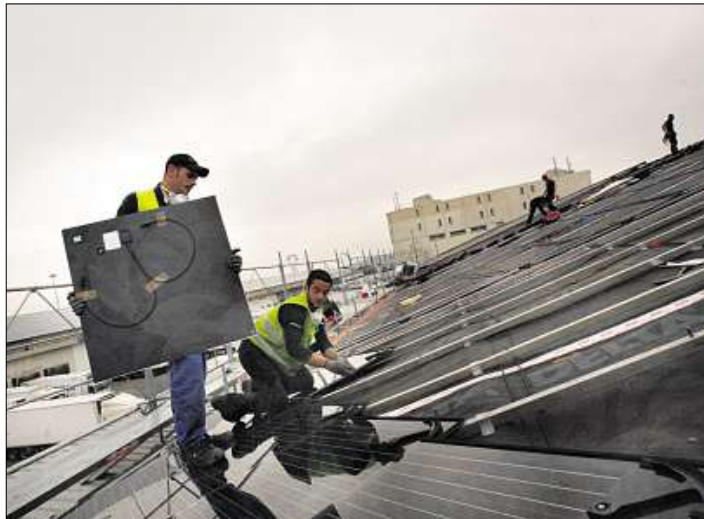
La première partie de la couverture en photovoltaïque solaire de Saint-Charles est en cours. La seconde tranche pourrait être remise en cause par le décret du gouvernement. Photos Ph. Rouah
