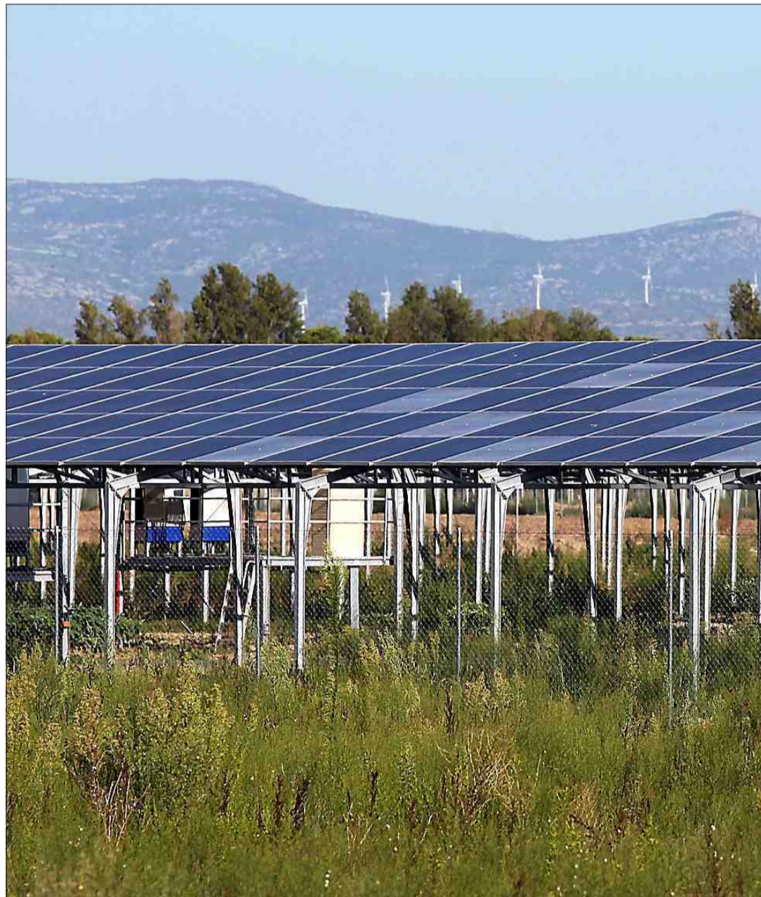
► La construction de ces capteurs est unique dans le département.
